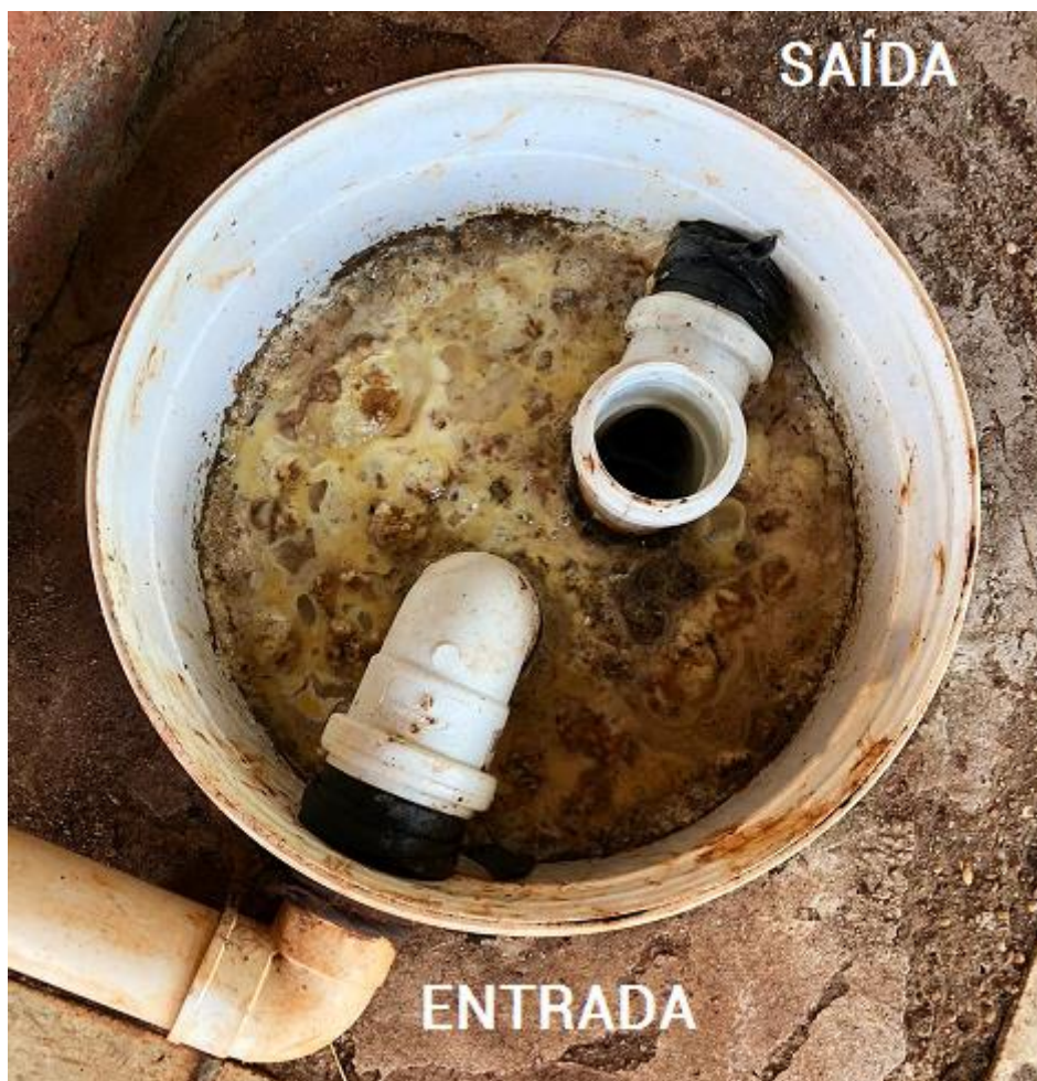
Figura 2: Foto da caixa de gordura instalada.
